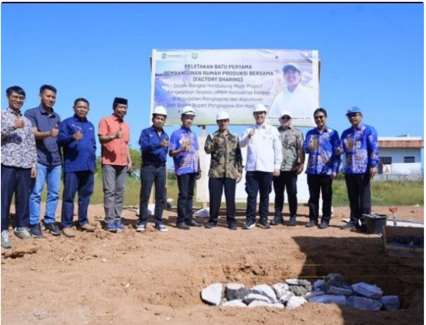
Peletakan Batu Pertama Pembangunan RPB Pengelolaan Garam
